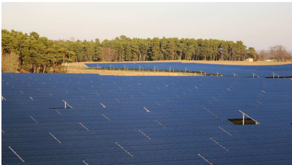
Figura 3 - Usina fotovoltaica de 28.8MW instalada na Alemanha.
