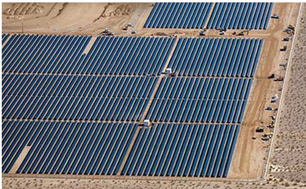
Figura 2 - Usina fotovoltaica com painéis de telureto de Cádmio, nos Estados Unidos.
