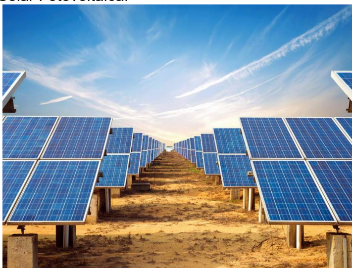
Figura 3 - Usina Solar Fotovoltaica.
